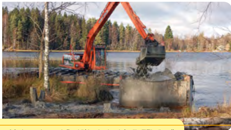
Syksyinen maisema voi olla mitä hienoin, aina ei ole näin. Tällä työmaalla otetaan 300 kuutiometriä tiukkaa savea juurakkoineen ylös.
