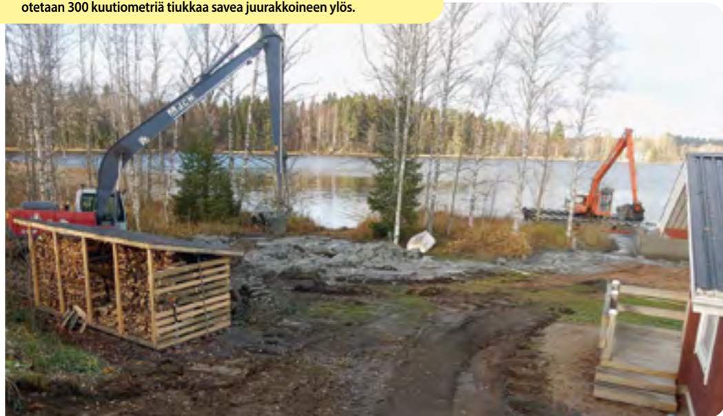
Syksyinen maisema voi olla mitä hienoin, aina ei ole näin. Tällä työmaalla otetaan 300 kuutiometriä tiukkaa savea juurakkoineen ylös.
