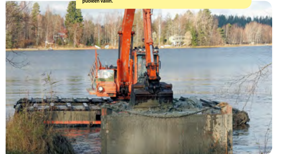
Kelluvan kuraproomuun (20 m 2 ) tasaus menossa, uittamalla täytetään vain puoleen väliin.
