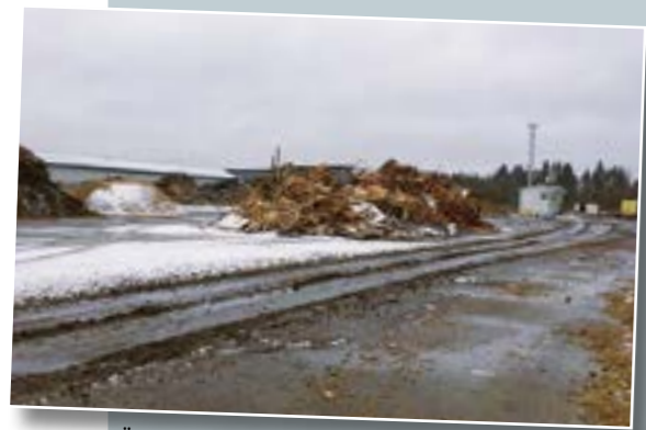
Änekosken biotuotetehtaan rakennusmateriaalien puupakkausten osat päätyivät Biolämmön polttoaineeksi.
