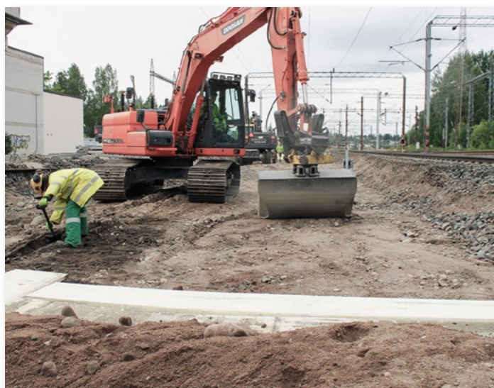
Radan alusrakenteen pinnan tasausta 3D-avusteisesti, maarakentaja upottaa lapiolla aikaisemmin esiin kaivettua kaapelia alusrakenteeseen.
