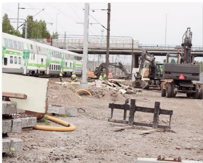
Ratapihojen vaihtenvaihtoajat ovat yleensä lyhyitä ja vaativat siitä syystä paljon kalustoa, viereinen junaliikenteellä oleva pääradanraide asettaa omat vaatimuksensa turvajärjestelyille.
