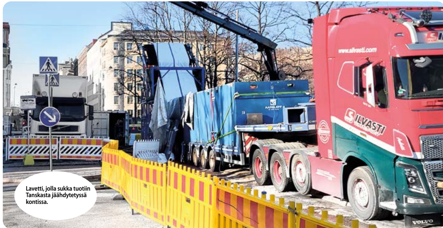
Kaivon päälle pystytetty torni, josta valkoinen sukka puretaan vedenpainolla saneerattavan putken sisään.
