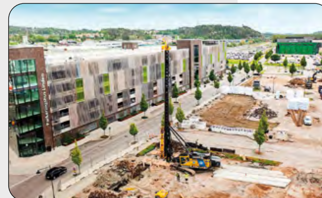
Green deal -sopimus velvoittaa rakentajat tulevaisuudessa yhä tiukempiin päästönormeihin. Kuva Kungsbackan rakennustyömaalta Ruotsista.
