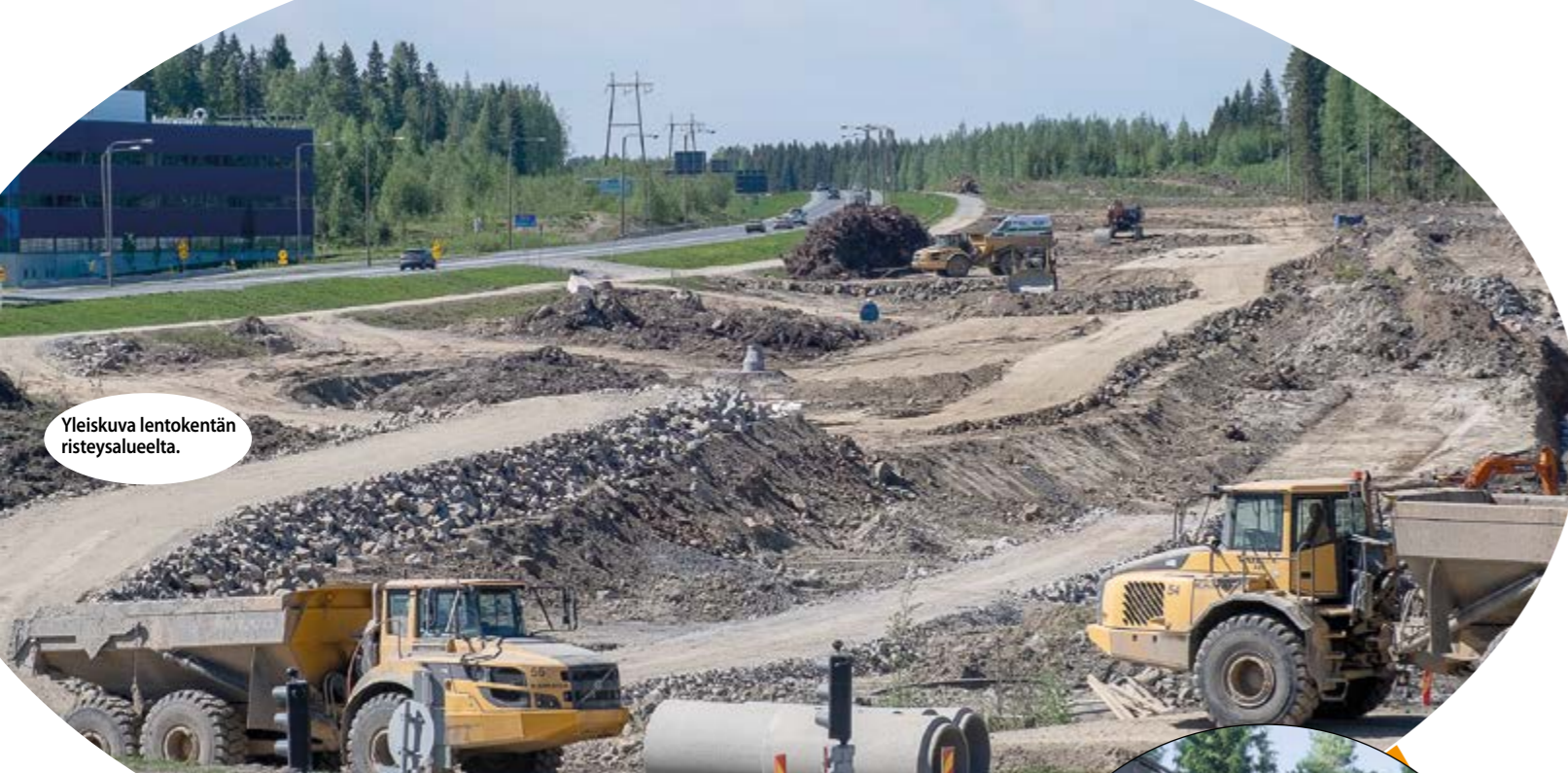
Louhetta tarvitaan paljon tien rakentisiin. Mittakaavaa kuvalle antaa 40 tonnin kaivukone.
