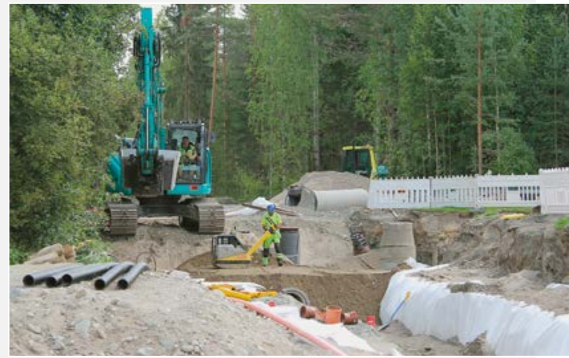
Uimaharjuun rakennettiin myös hulevesiviemärit.
